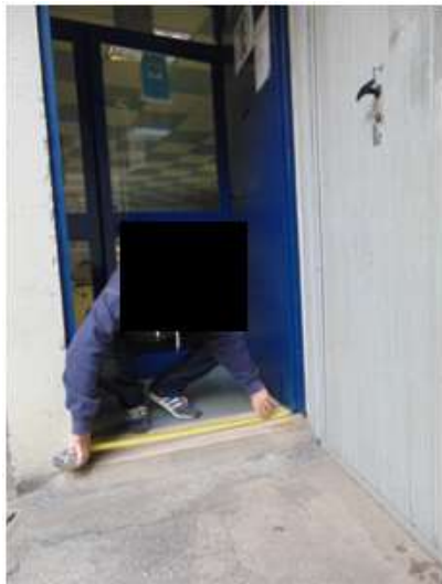
Fotografia del rilievo del passaggio minimo della porta al netto dell'anta
