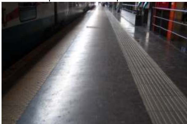
Fotografia di banchina ferroviaria con due diverse indicazioni tattili a terra. Una indicazione è una striscia a terra in prossimità del bordo esterno del marciapiede verso il binario. L'indicazione è di colore giallo con elementi a rilievo semisferici per avvisare del pericolo. L'altra indicazione è un percorso tattile di colore grigio chiaro.
