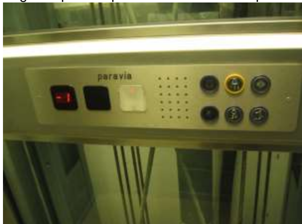
Fotografia di pulsantiera con indicazioni luminose a rilievo e in Braille
