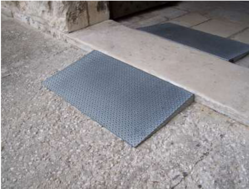
Fotografia di soglia esterna ed interna con rampe inclinate removibili
