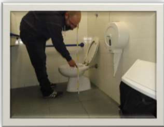
Fotografia del rilievo dell'altezza del sanitario al netto del copri water
